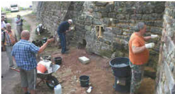
Arbeiter bei der Sanierung des Mauerwerks der Teufelsburg. Foto: Johannes A. Bodwing
